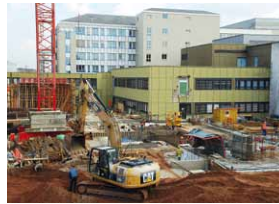
So sah die Baustelle des Bettenhauses C Mitte Februar aus
