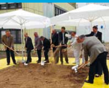
Spatenstich: Bettenhaus C Seite 8
